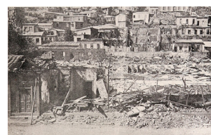
Figura 36. Incendio 24 de diciembre de 1908, cité de calle Colón. Fuente: Revista Sucesos 1908.
