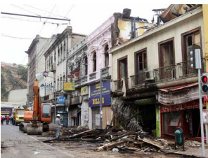
Figura 60. Edificio posterior a incendio 26 de enero de 2012. Fuente: Campos 2012.
