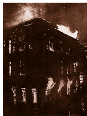
Figura 37. Incendio Pasaje Ross, 1914. Fuente: Revista Sucesos 1914.
