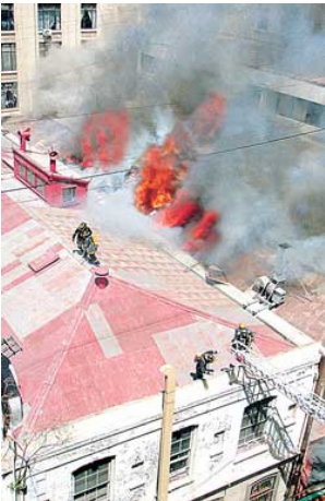
Figura 51. Incendio 5 de enero de 2001 en Avenida Cochrane. Fuente: http://www.mercuriovalpo.cl/site/edic/20010105203732/pags/20010106012635.html
