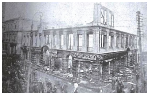
Figura 38. El gran incendio de Valparaíso Pasaje Ross. Fuente: Pacífico Magazine 1914.
