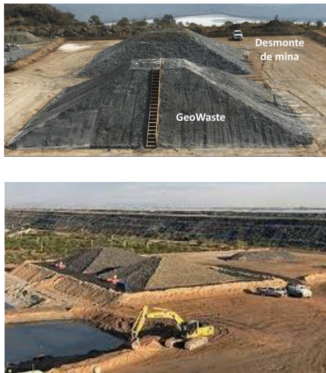
Figura 1-10: Pruebas piloto de pilas compactadas de mezclas de relaves filtrados y estériles mineros (GeoWaste™). Fuente: GoldCorp.
