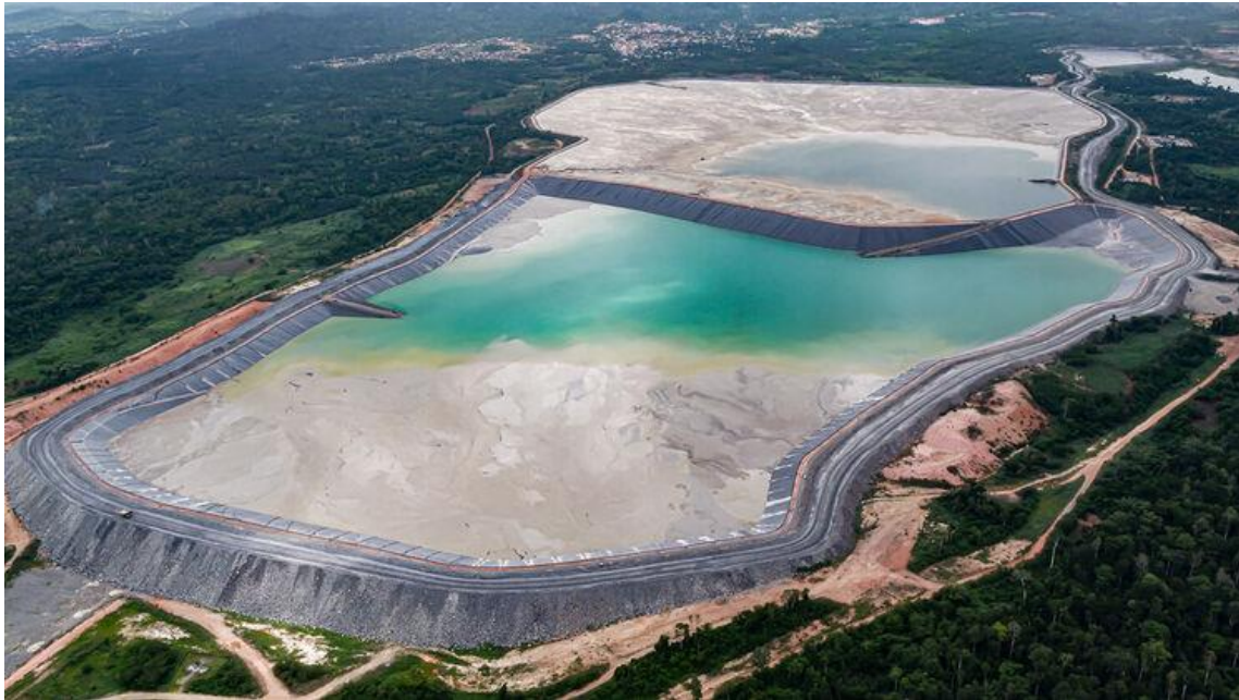
Figura 1-1: Tranque de relaves. Akyem Mine TSF Cell 1, Ghana, África.
