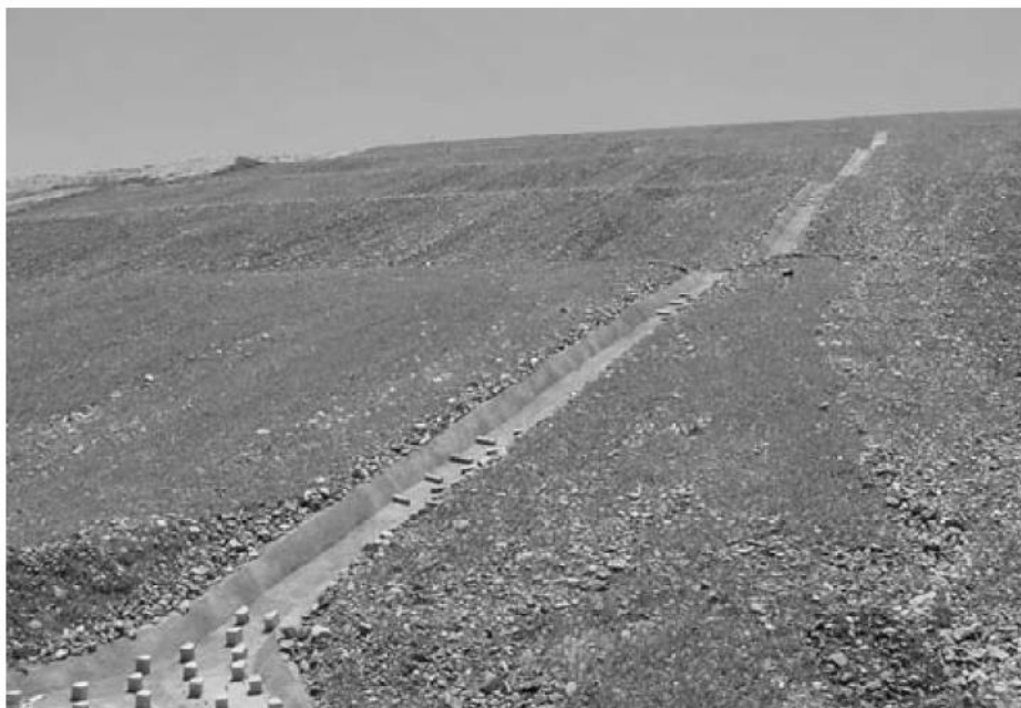
Figura 1-9: Co-disposición en cobertura de cierre de Daggafontein Gold TSF, Sudafrica.
