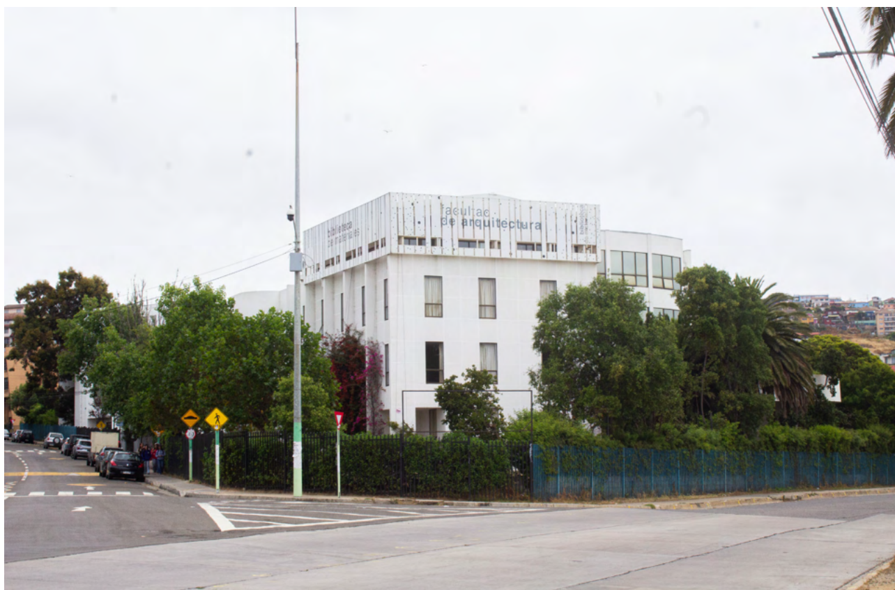
Figura 43 Fotografía frontal exterior de la Facultad de Arquitectura UV: área de Archivo MW
