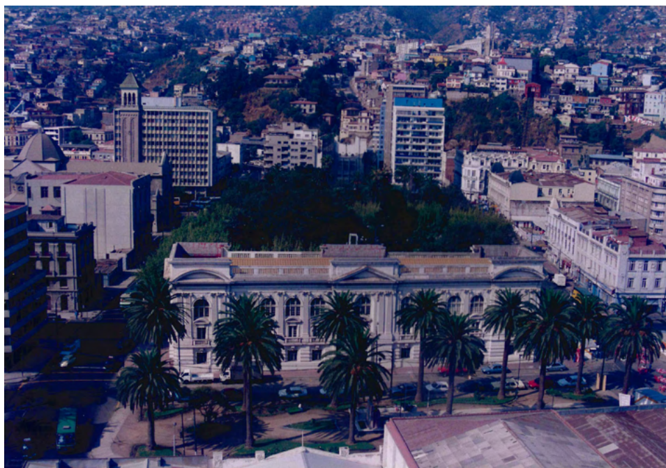
Figura 55 Fotografía de fachada de la Biblioteca Santiago Severín de Valparaíso
