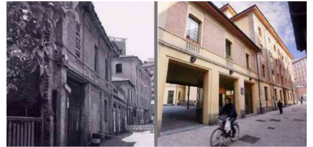
Fig. 6 Edificios antes y después de la rehabilitación. Fuente: Sánchez (2010).
