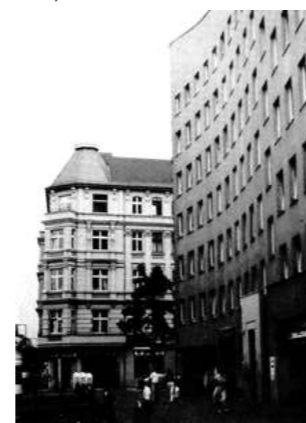
Fig. 10 El edificio de Siza Vieira del bloque 121 frente a uno renovado (Baquero, 1988).
