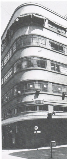
Edificio Oberpaur - S. Larrain - J. Artega (1929-30)
