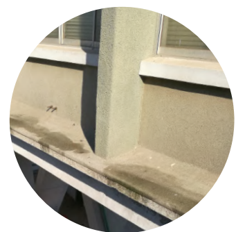
3 Enlucido de hormigón con grava verde
