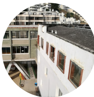
2 Tabiquería pintada blanco
