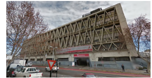
Fig. 47 Edificio Central de Correos Fuente: https://www.archdaily.cl/cl/879545/guia-de-arquitectura-moderna-de-santiago-20-obras-que-debes-conocer?ad_medium=gallery
