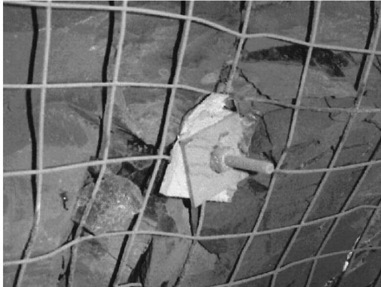
Figura 4.13: Pernos de roca mecánicos.
