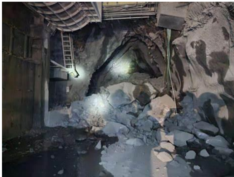
Figura 4.3: Estallido de Rocas mina El Teniente 2024.
