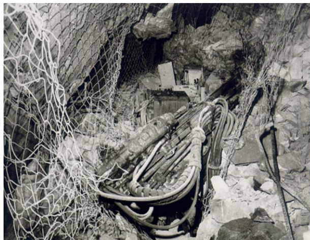
Figura 1.1: Estallido de rocas sector Teniente - 4 norte fw production level ocurrido en 1987.
