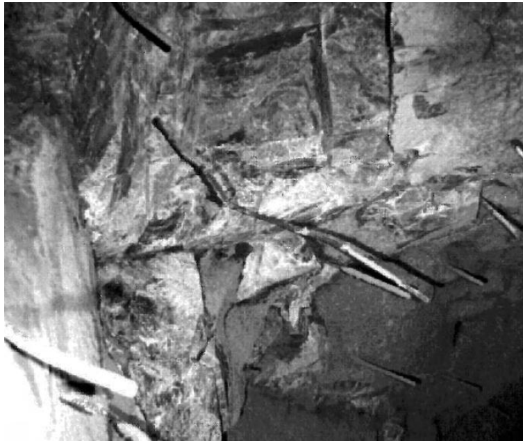
Figura 4.12: Barras de refuerzo completamente inyectadas.
