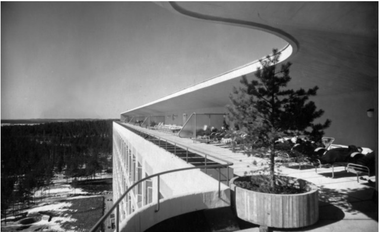
Fig. 26 Terraza en la azotea para cura de reposo. Fuente: Gustaf Welin, Alvar Aalto Museum. Tomada de: Alvar Aalto Foundation, Finlandia.
