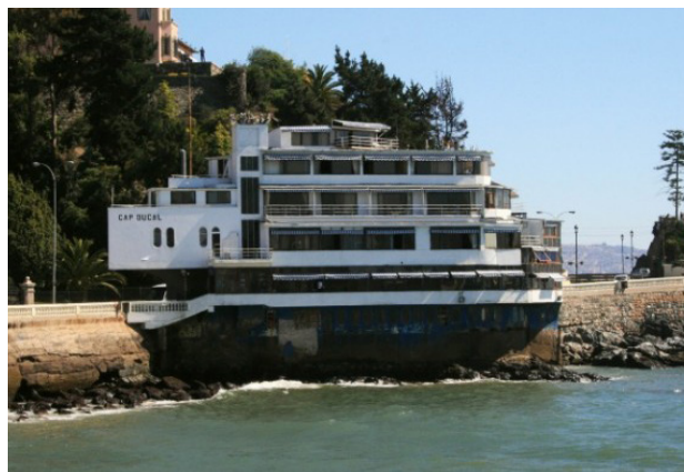
Fig. 103 Edificio Cap Ducal en la actualidad. Tomada de: https://www.disenoarquitectura.cl/restaurante-cap-ducal-de-roberto-davila/
