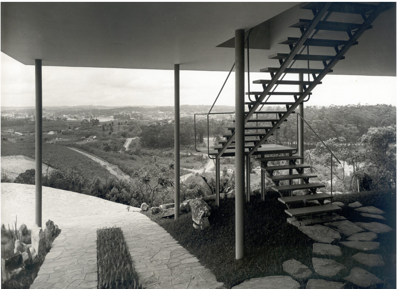
Fig. 83 En la casa de Vidrio, la elevación del volumen por sobre el terreno, permite crear un área de acceso protegido por un plano superior, similar a el cobertizo anterior. Tomada de: https://arquitecturaviva.com/obras/casa-de-vidrio#lg=1&slide=5
