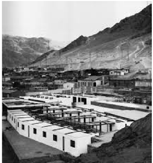
Fig. 114 Vista aérea Hostería de Chañaral, Luis Ladrón de Guevara. Tomada de: Galeno - Ibaceta, C. (2013) Turismo y arquitectura moderna en el reconocimiento de los territorios desérticos del norte de Chile: el Consorcio Hotelero Nacional y HONSA. AS N°44, 82-105.
