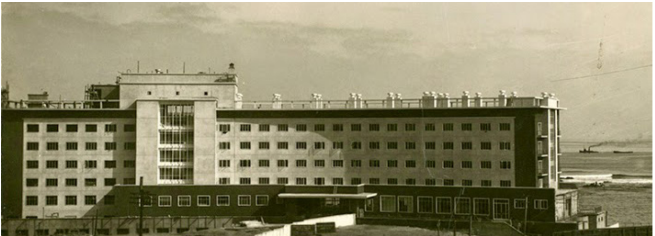
Fig. 65 Vista fachada nororiente del edificio en obras, Archivo Antieditores. Tomada de: http://cgaleno.blogspot.com/2014/09/la-concurrida-inauguracion-del-hotel.html
