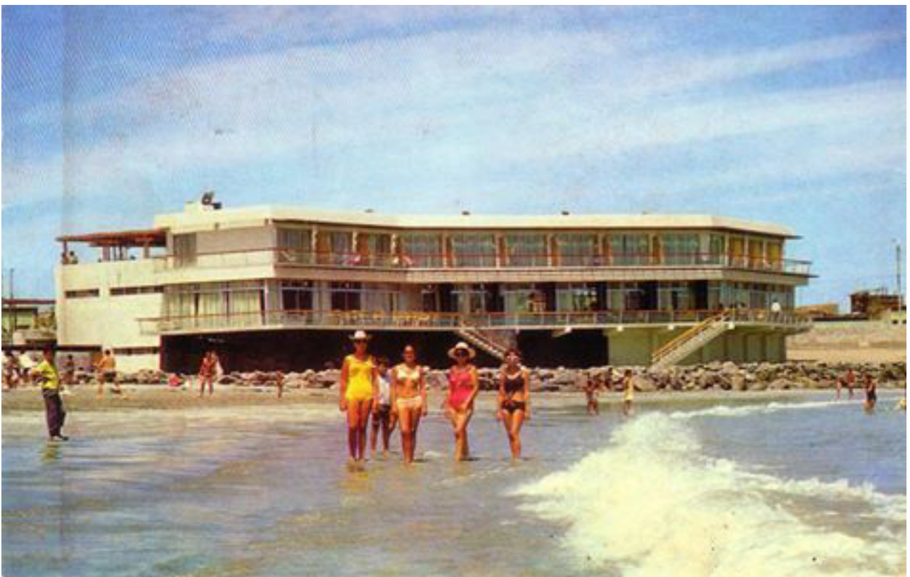
Fig. 67 Vista fachada norte de la Hostería Cavancha desde la playa. Tomada de: https://elsoldeiquique.cl/hosteria-cavancha-uno-de-los-ultimos-vestigios-de-la-honsa-la-hoteleria-estatal/
