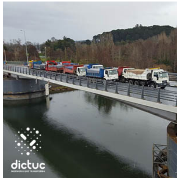
Figura 5.4.2: Prueba de carga efectuada en el puente Cau Cau en la ciudad de Valdivia (DICTUC)
