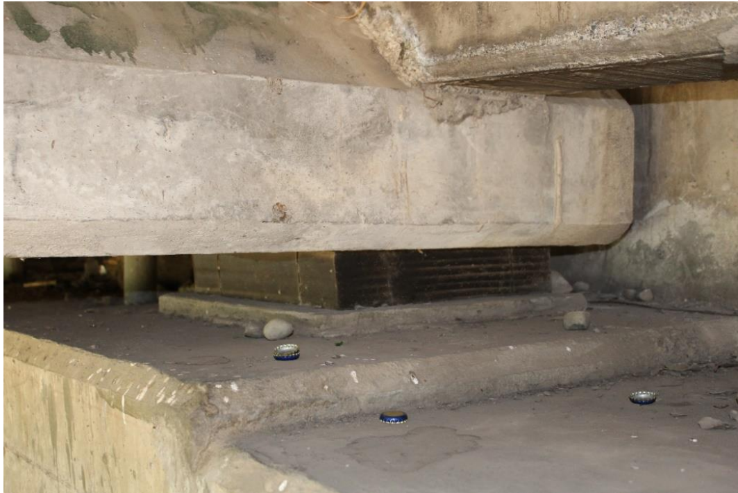
Figura 106 Foto de elastómero en Estribo oriente.
