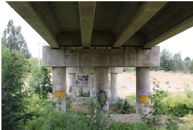
Figura 94. Foto Cepa 2 Puente Águila Norte.
