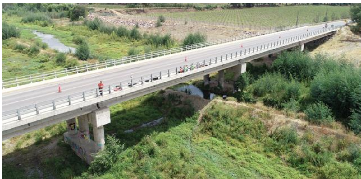
Figura 17 Vista General de Puente Águila Norte. Foto Proyecto FONDEF.
