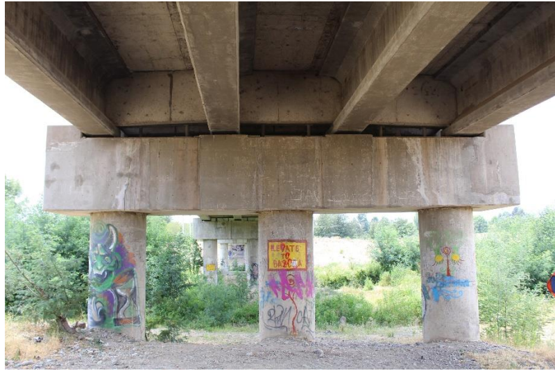
Figura 93. Foto Cepa 1 Puente Águila Norte.
