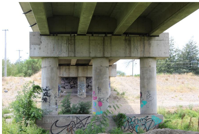
Figura 95. Foto Cepa 3 Puente Águila Norte.
