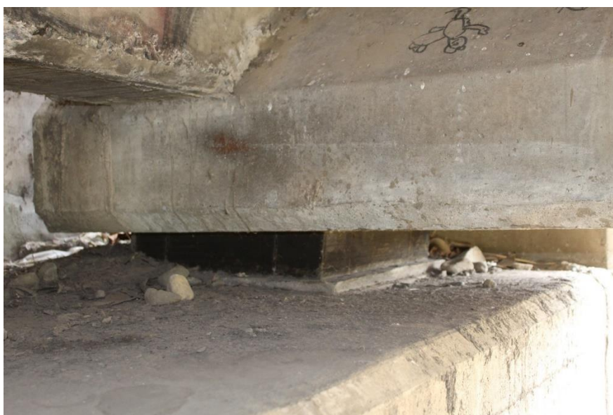
Figura 105 Foto de elastómero en Estribo poniente.
