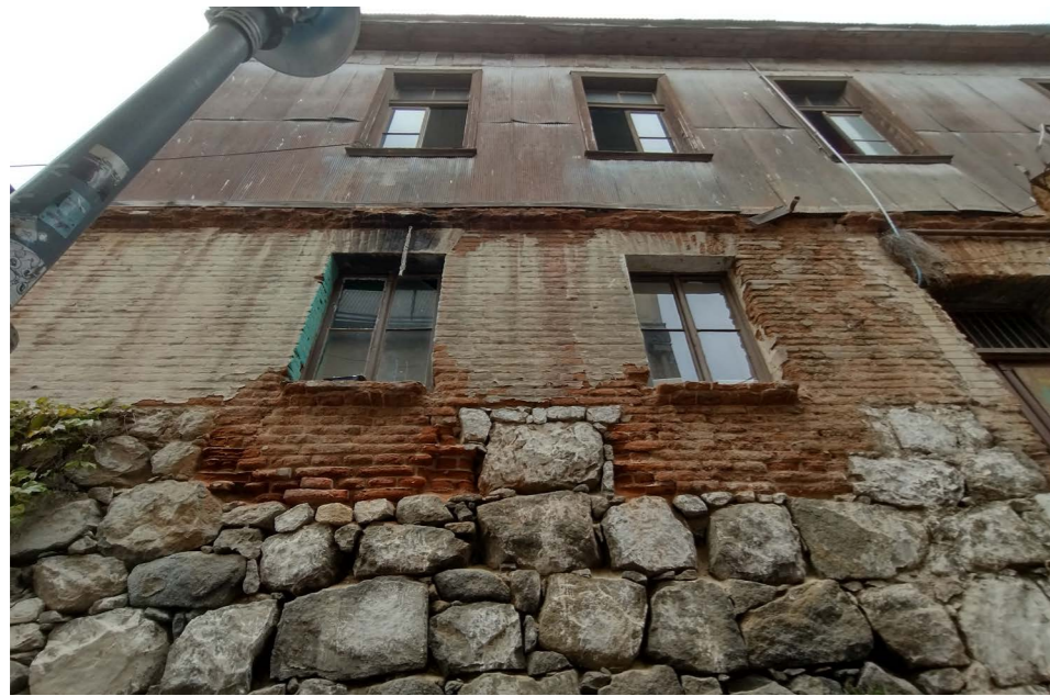
Figura 3 Fotografía de inmueble de sistema constructivo mixto en Valparaíso. Fuente: Archivo propio, 2022.
