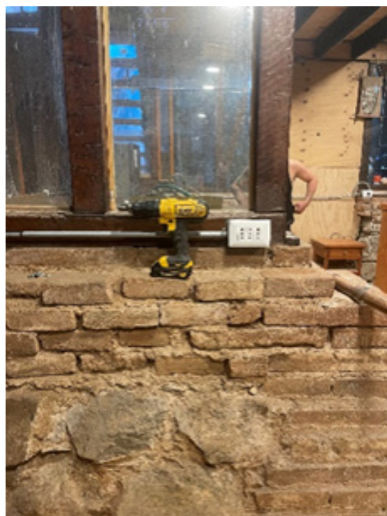
Fig. 157 Caso 2. Almirante Montt #97. Fotografías del muro de albañilería simple sobre fundación de mampostería en piedra.
