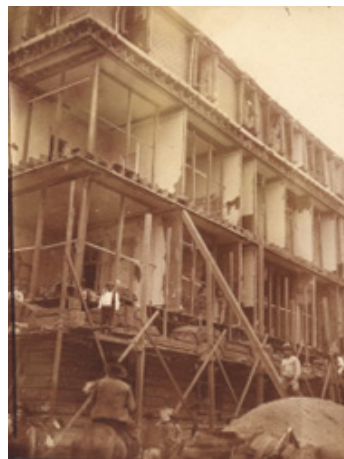
Fig. 62 Fotografías inmuebles sistema constructivo mixto, albañilería de ladrillo simple con entramado de madera, tras terremoto de 1906 en Valparaíso: Izq. Desprendimiento de fachada con peligro de derrumbe. Der. Plaza Echaurren. (Hardy, 1906).
