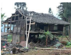
Fig. 13 Fotografías del colapso en estructura de entramado de madera rellenos con mampostería (Qu et al., 2015).
