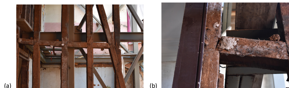
Fig. 95 Fotografías separación de elementos de entramado de muro encontrados en el Caso 1: Calle Higueras #179: (a) muro desnivelado; (b) unión caja y espiga con espera traccionada producto del asentamiento de la vivienda.
