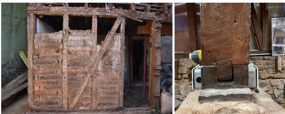
Fig. 2 Fotografías del sistema constructivo tradicional de entramado de madera relleno con adobillo: (a) entramado de muro; (b) ensamble caja y espiga.
