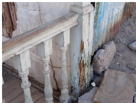
Fig. 26 Ejemplo de fotografías de levantamiento de estado de viviendas con valor histórico-arquitectónico, localidad de Pica 2023. Autoría propia.
