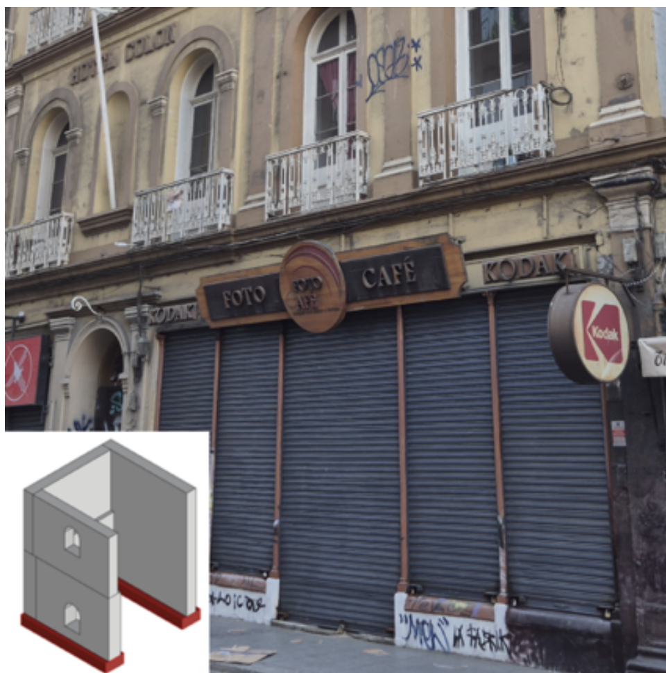
Figura 26. Fachada exterior de hotel Colón. Elaboración propia.
