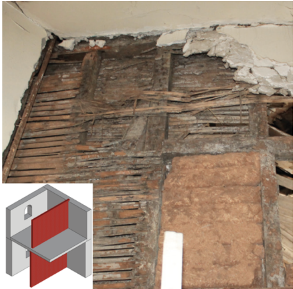
Figura 29. Detalle Tabique adobillo. Elaboración propia.
