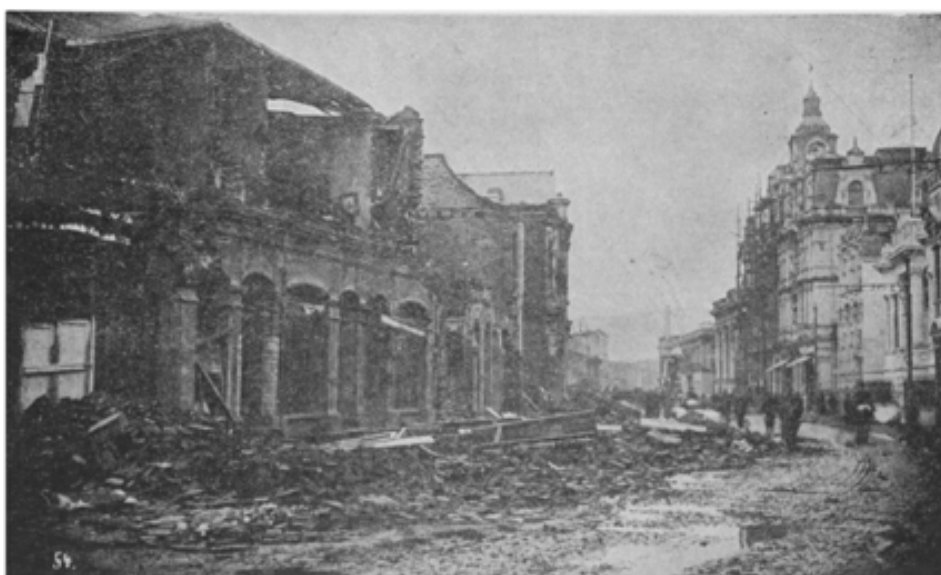
Figura 2. Fachadas derrumbadas en la calle Condell Para el terremoto de 1906 (Rodríguez y Gajardo, 1906).
