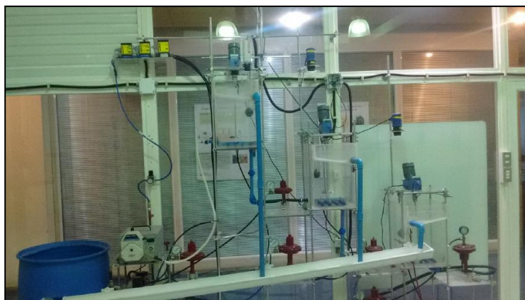
Figura 2.1: Circuito de celdas de flotación rougher
