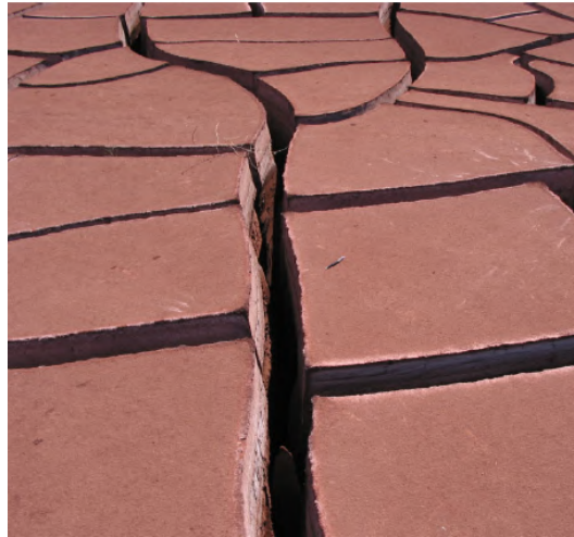
Figura 2.1: Agrietamiento Superficial Observado en un Suelo Arcilloso en Clima Seco.
