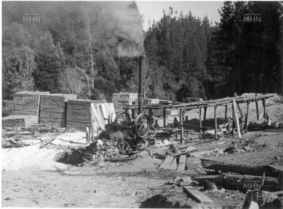
Ilustración 27 Aserradero con Locomóvil, alimentada de leña. Fuente http://www.fotografiapatrimonial.cl/p/15813
