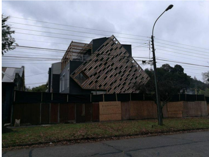
Ilustración 11: Estado actual de la casa, fue demolida completamente entre 2016 y 2017, dando lugar a la construcción de un proyecto hotelero. Fuente fotografía: Gentileza Alejandro Belmar, ciudadano puconino, 2017.
