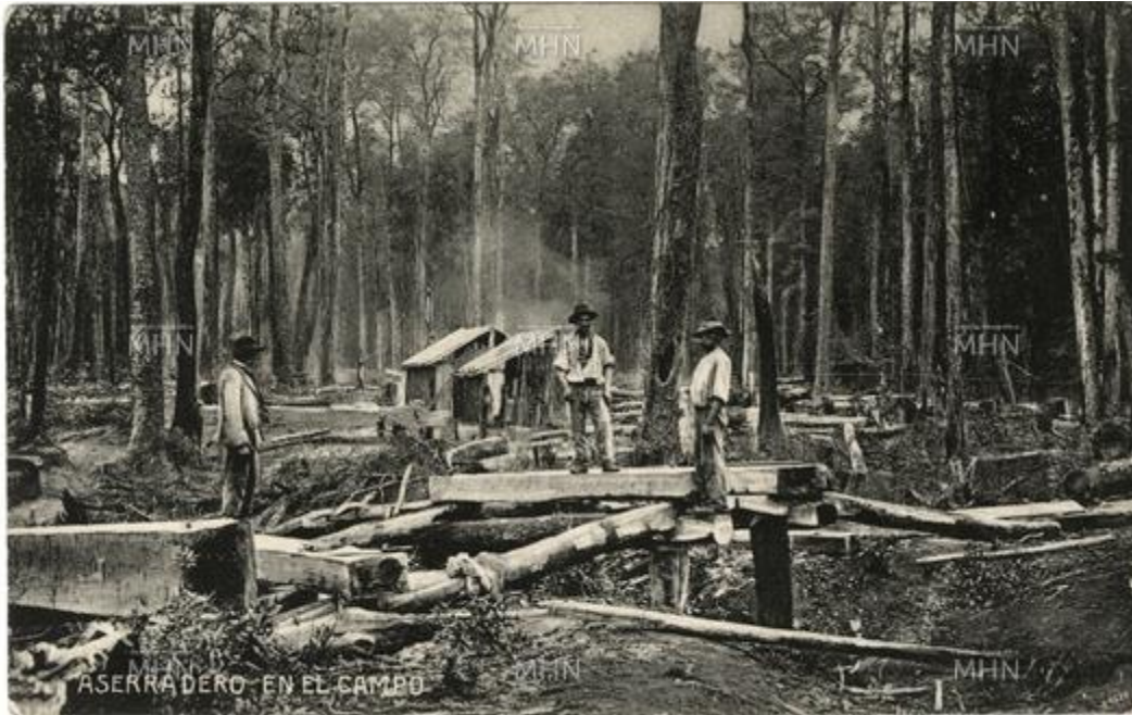
Ilustración 24 Aserreo con a mano con “catre”. Aserradero en el campo hacia 1900, Fotografía disponible en http://www.fotografiapatrimonial.cl/p/17022
