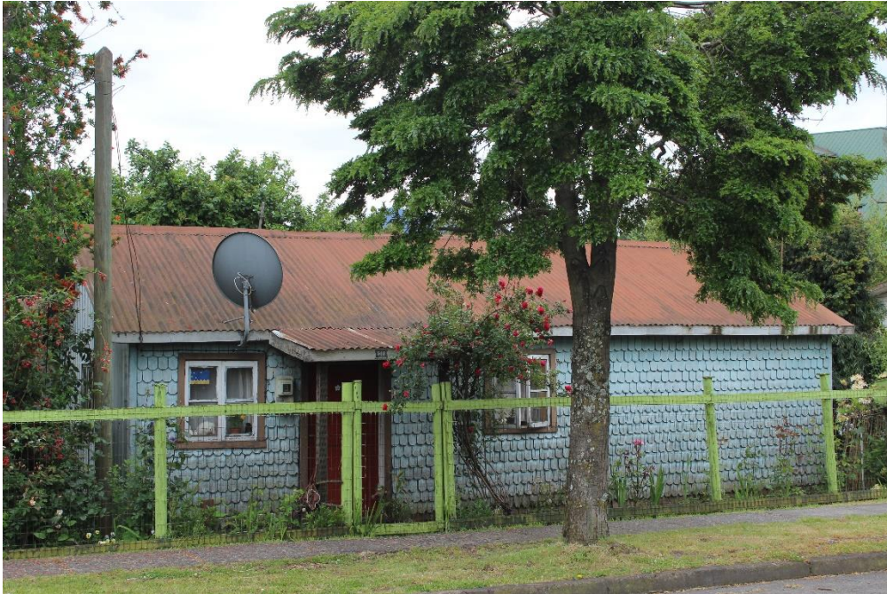
Ilustración 32 Tipología de vivienda básica con revestimiento de tejuela. Fotografía Gabriela Sanzana 2018.
