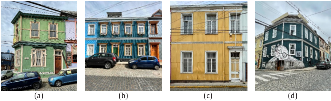
Figura 54 Fotografías de viviendas de entramado de madera en cerro Concepción.
