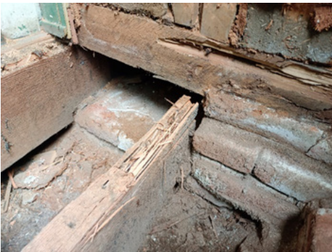
Figura 121 Envigado de piso del primer piso, amarrada entre ladrillos de albañilería.
