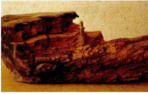
Figura 25 Daños producidos por hongos de pudrición parda (Arriaga et al., 2002).
