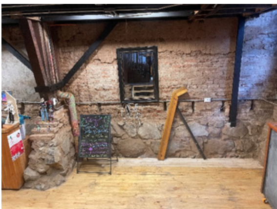
Figura 131 Fundaciones de piedra y ladrillo, subterráneo del inmueble.
