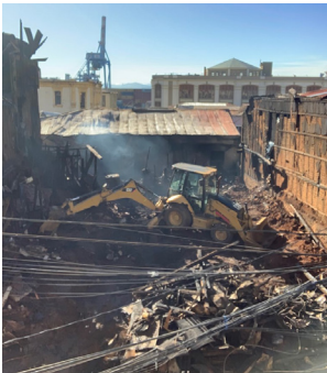
Figura 48 Cierro perimetral del sitio edificio habitacional Almirante Riveros, septiembre 2025. Fuente: CSPM, 2025.
