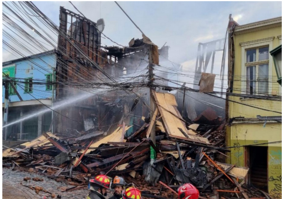
Figura 46 Edificio habitacional Almirante Riveros, Mayo 2025. Fuente: DGP, 2025.
