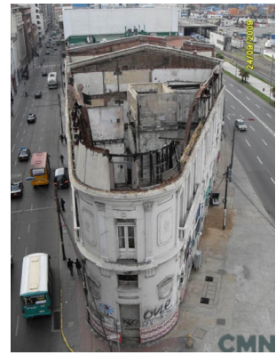
Figura 36 Edificio Luis Cousiño, 2009. Fuente: CMN, 2025.
