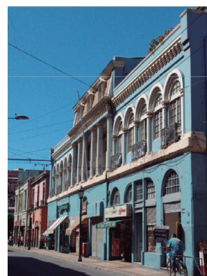
Figura 23 Edificio Subercaseaux fachada principal Calle Serrano, previo a incendio 2007. Fuente: Ramírez, Alvarado, Gelos, 2013.
