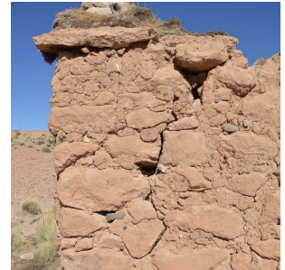
Fig. 11 Sistema constructivo altiplánico de mampostería en piedra.
