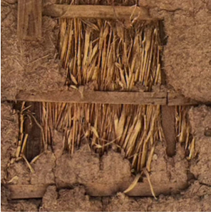
Fig. 48 Tabique de madera con relleno de adobes.
