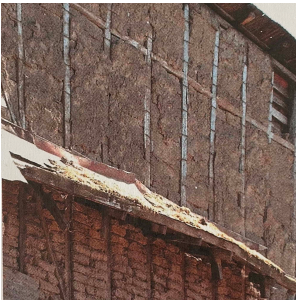
Fig. 15 Estructura mixta de tierra y madera en edificación en el barrio Yungay, Región Metropolitana. ©Natalia Jorquera.
