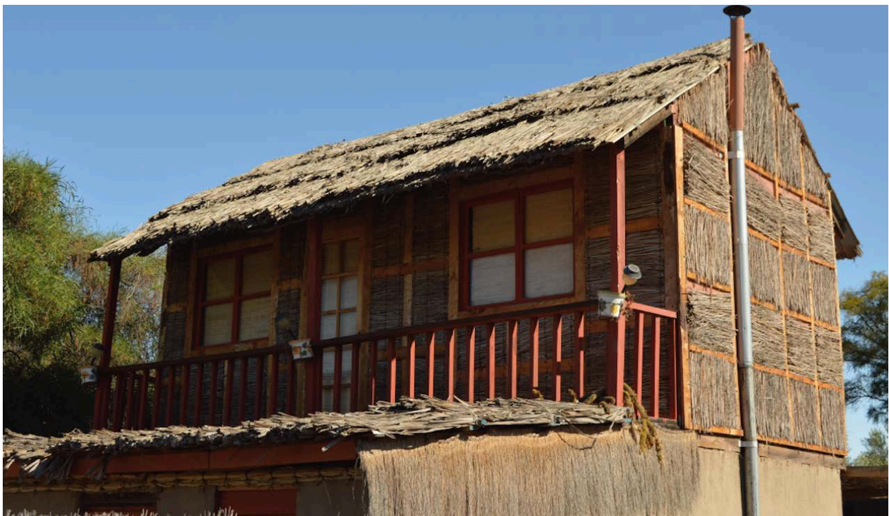
Fig. 52 Vivienda construida con sistema de quincha con brea, en la comuna de Totoral, Región de Atacama. ©Valentina Cabrera
