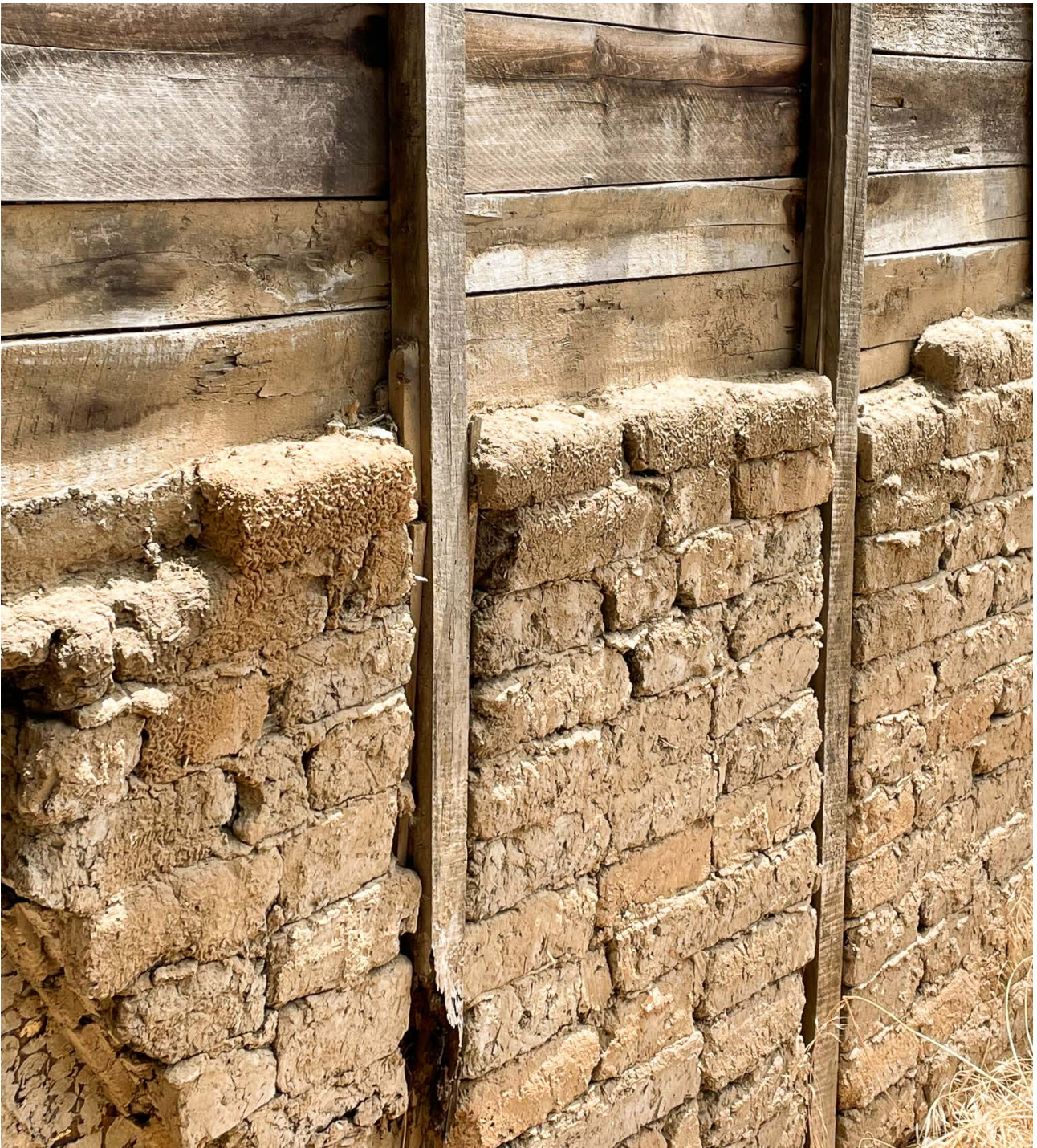
Fig. 48 Tabique de madera con relleno de adobes.
