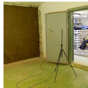
Fig. 36. Ensayo comportamiento acústico. ©Acevedo et al.
