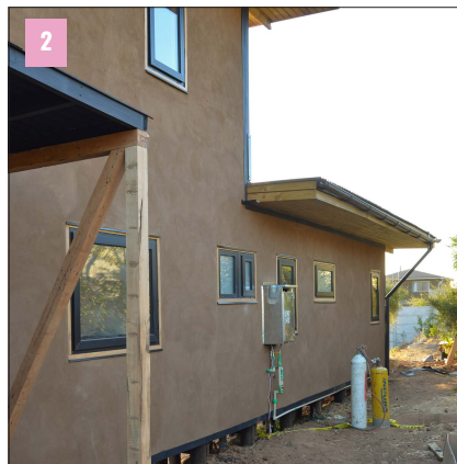
Fachada norte Fuente: Elaboración propia
