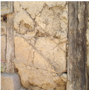
Fig. 39-40 Técnica de adobe en pandereta.
