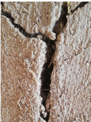
Fig. 26 En la imagen se observa como las fibras vegetales actúan como conector del aglomerado de tierra cruda, dándole estabilidad a la mezcla.
