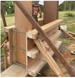
Fig. 32 Encofrado de Tapial escala 1:1.
