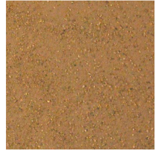
Fig. 18 Detalle revoque fino elaborado con tierra cruda (proporción 1:2 de tierra arcillosa y arena fina de río, más aditivos). ©Claudia Bustamante
