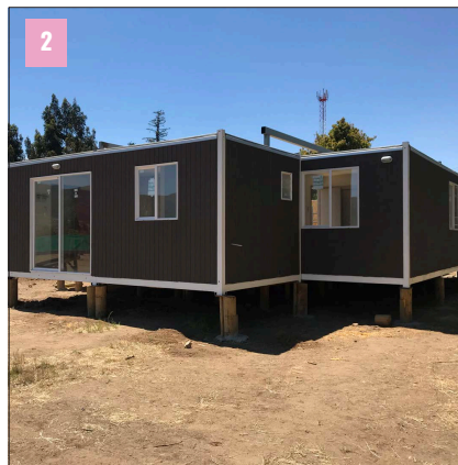
Fachada poniente - Modularidad Fuente: Archivo de autor
