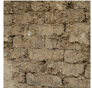
Fig. 36 Muro construido con sistema de adobes con algunos refuerzos metálicos.
