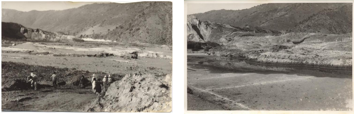
Figura 1-8 –a) Campamento minero el cobre sepultado bajo relave b) Cancha de campamento el cobre cubierta por relave (Valenzuela, 2016)
