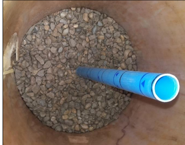
Figura 3-4 - Drenaje basal en base de cámara de calibración Fuente: Elaboración Propia
