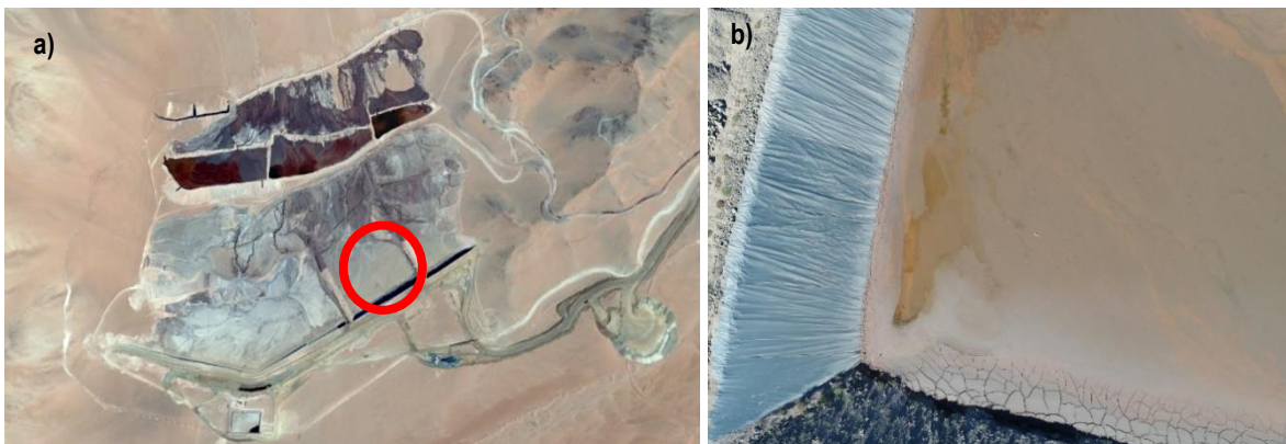
Figura 4-3 –a) Depósito de relaves faena Cerro Negro Norte b) Estado actual cubeta central
