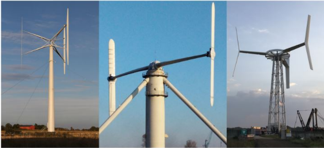
Figura 3.12: Izquierda: H-rotor de 200 kW en Falkenberg. Centro: prototipo terrestre NENUPHAR de 600 kW. Derecha: Turbina Anew-B1 de 1.5 MW [24]
