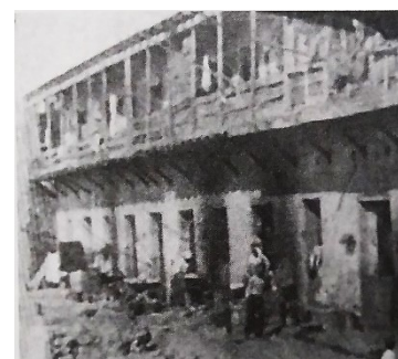
“Construcción de dos pisos compuesta de cuartos redondos, sin patio y con salida a la calle”. Fuente: MINVU (2004). Chile un siglo de políticas de vivienda y barrio . Santiago, Chile: Pehuén Editores Ltda.
