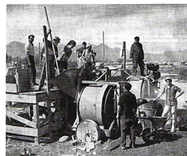
“La Operación Sitio considera la autoconstrucción como parte integrante de su modo de operación”. Fuente: MINVU, 2004.
