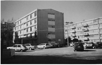
Bloque de viviendas, Población 15 Norte, Viña del Mar, Chile. Fuente: MINVU, 2004.
