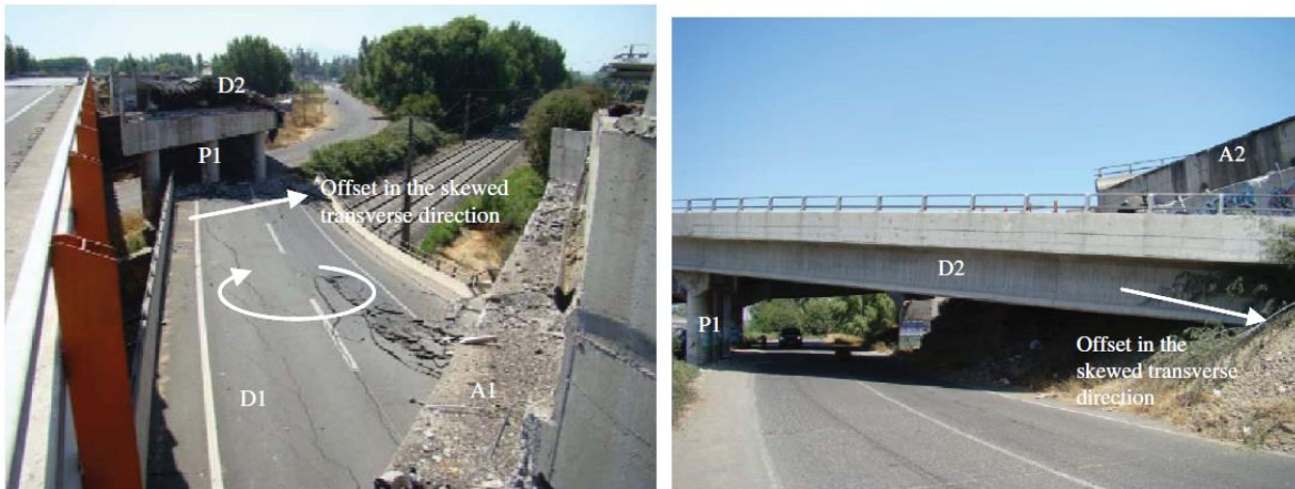
Figura 2-15 – Geometría fuerza de impacto en puentes
