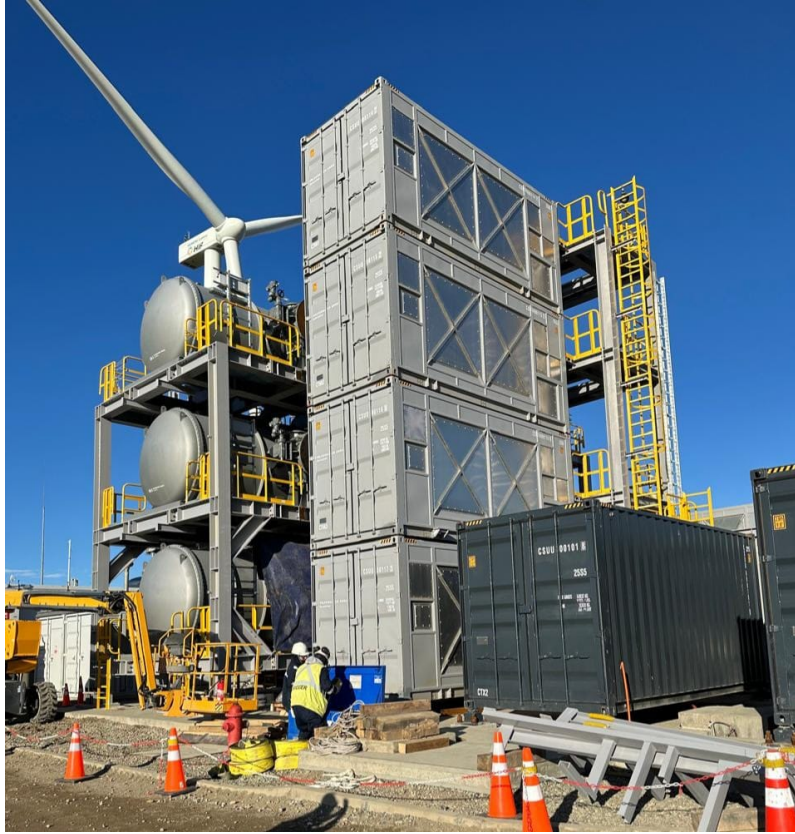
Figura 6.14: Instalación de un sistema de Captura Directa de Aire (DAC) en la planta Haru Oni de HIF [80].
