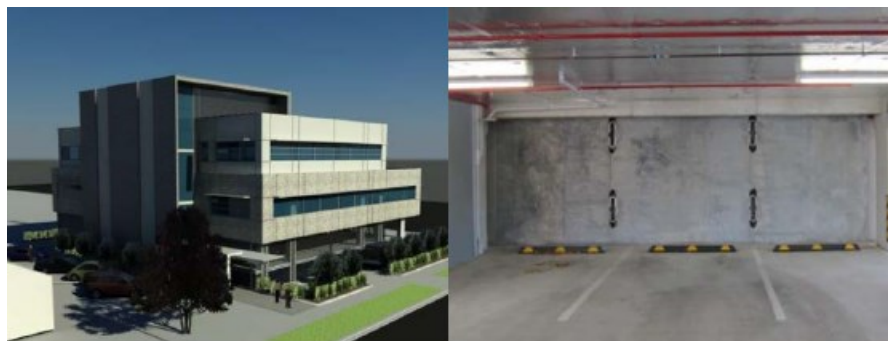
Figura 2.20: A la izquierda el Edificio Southern Cross Hospital. A la derecha muros mecedores en los estacionamientos.
