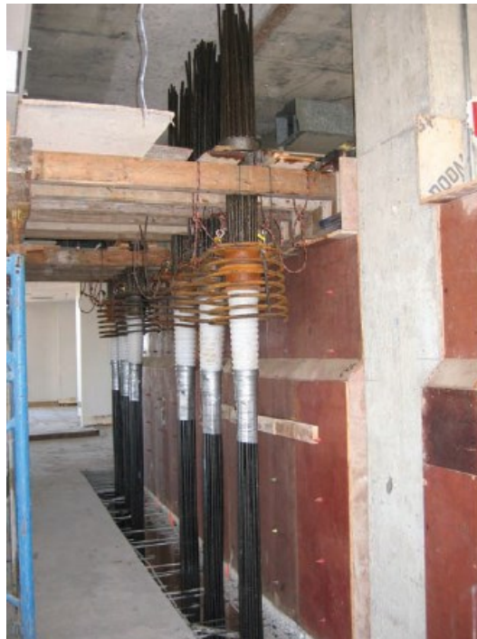
Figura 2.18: Tendones de cables en El edificio 2850 Telegraph [19].
