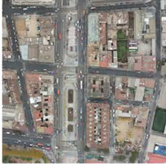
Fig. 1: Fotografía de la zona de estudio levantada mediante el uso de dron.
