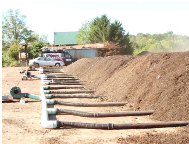
Figura 7: Pila estática con aireación forzada.
