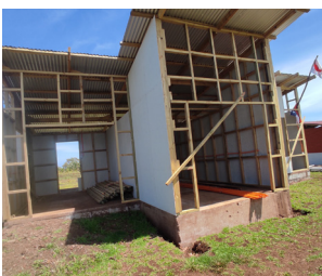
Fig. N°79: Foto fachada este casa en construcción. Fuente: Priscilla Zúñiga Rivera.
