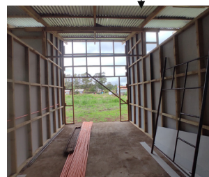
Fig.N°81: Foto interior dormitorio 1. Fuente: Priscilla Zúñiga Rivera.
