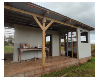
Fig. N°78: Foto taupea y pasillo distribución, espacio articulador cumpliendo doble función. Fuente: Priscilla Zúñiga Rivera.
