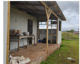
Fig. N°77: Foto fundación de bloques de hormigón. uente: Priscilla Zúñiga Rivera.
