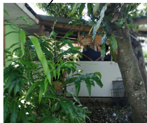
Fig.N°51 : Vista Taupea en construcción. Fuente: André Baradit Soto.
