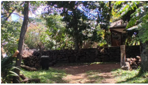
Fig.N°39: Detalle pirca de acceso divisoria de terreno. Fuente: Priscilla Zúñiga Rivera
