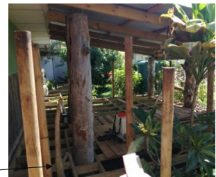
Fig. N°56: Foto Taupea en construcción. Fuente: André Baradit Soto.
