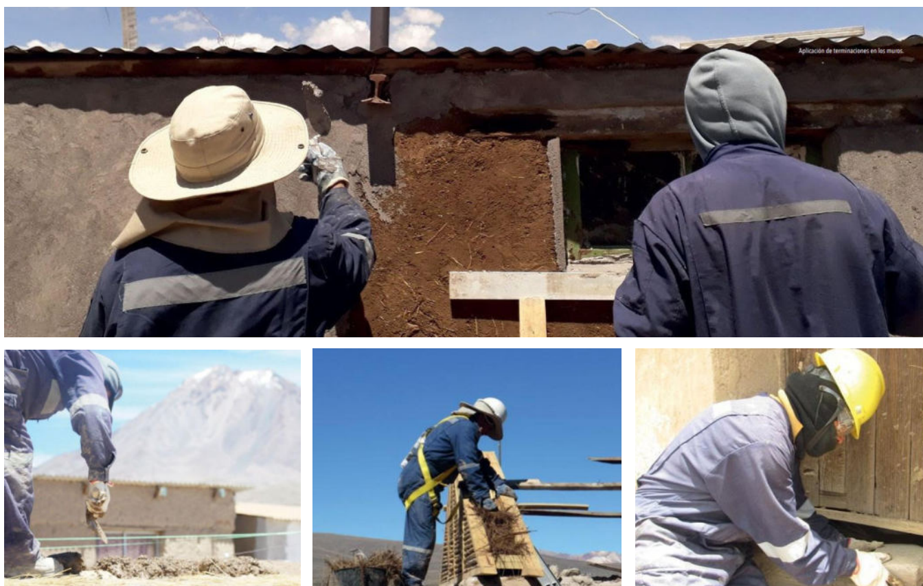
Fig 7. Registro Fotográfico Programa de Rehabilitación Tacora Fuente: "El último Malku. Paisaje cultural de Tacora" (2019)
