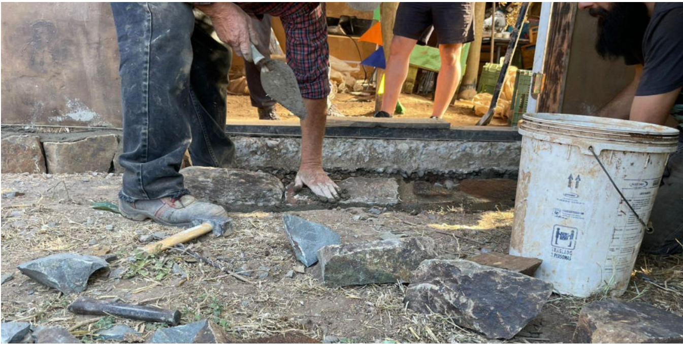
Fig 51. Proceso de colocación de piedras en el cimiento del muro de la escuela. Crédito: Registro personal.
