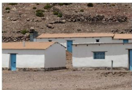
1 Restauración de 52 fachadas
