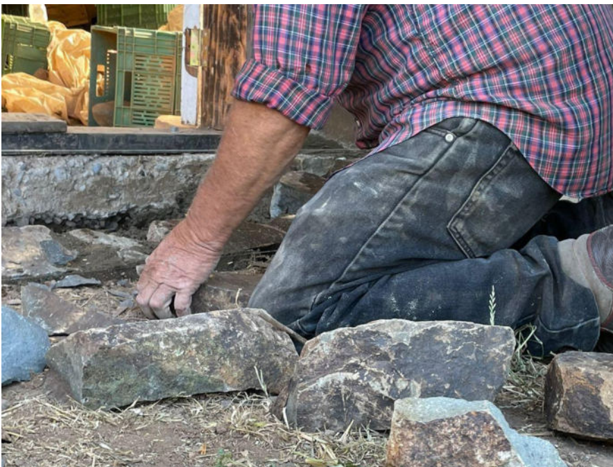
Fig 52. Proceso de colocación de piedras en el cimiento del muro de la escuela. Crédito: Registro personal.
