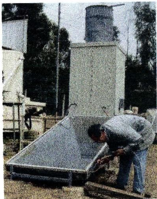
Imagen 4.6 Instalación tuberías colector
