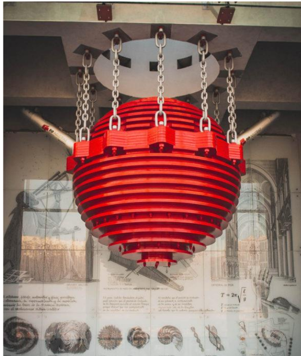
Figura 6.2: Amortiguador de masa sintonizada del edificio corporativo de la CChC. Fuente: https://ohstgo.cl/wp-content/uploads/2021/12/LAS-CONDES_Edificio-CChC_x3-1035x687.jpg
