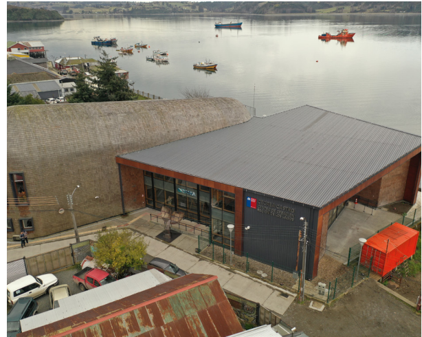
Imagen 51: Acceso CECREA Castro Vista Sur
