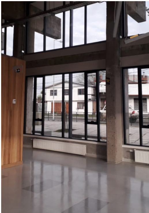
Imagen 48: Vista interior CECREA Valdivia fachada vidriada Recuperado de: Elaboración Propia Fecha: 13-04-2019
