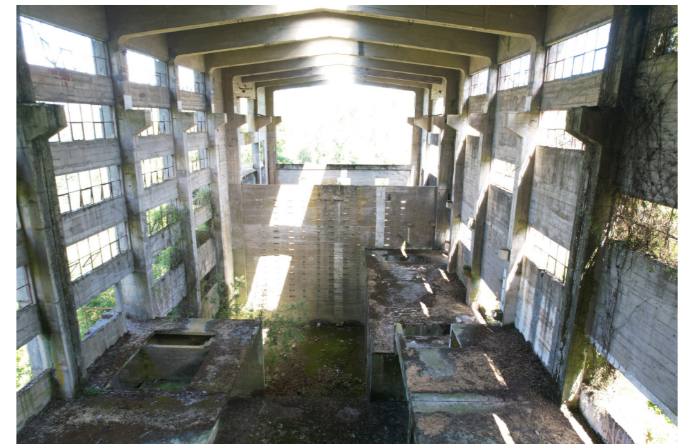
Figura 34: Fotografía interior edificio principal y sus entradas de luz. Fuente: Elaboración propia, 2022.
