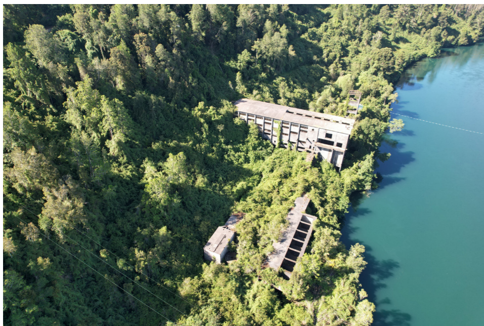
Figura 36: Fotografía aérea de emplazamiento. Fuente: Elaboración propia, 2022.
