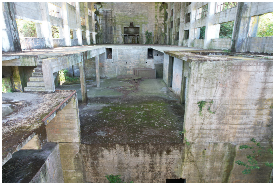
Figura 35: Fotografía interior edificio principal y sus distintos niveles. Fuente: Elaboración propia, 2022.
