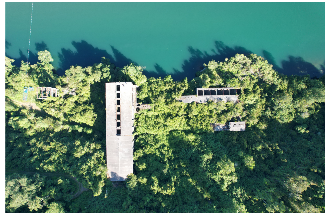
Figura 20: Fotografía aérea sacada por dron. Fuente: Elaboración propia, 2022.
