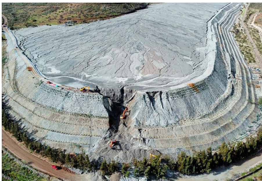
Figura 4: Depósito de relaves correspondiente al tranque de Minera Las Cenizas, Chile, el cual presentó una falla local asociada a escurrimientos superficiales durante eventos de lluvias intensas ocurridos en 2024. El caso evidencia la importancia del manejo de aguas y la estabilidad física en depósitos de relaves. Fuente: Alvarado (2024), Reuters.
