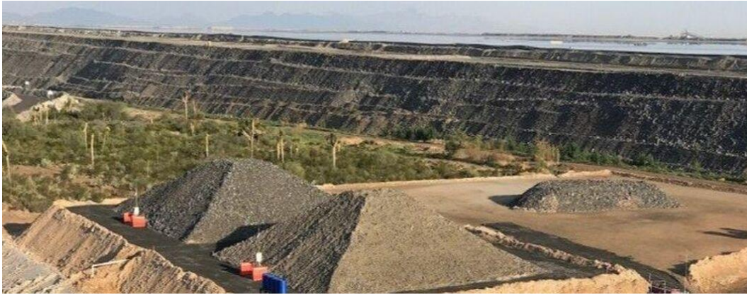
Figura 10.: Ejemplo de pruebas piloto o trial pads asociadas al desarrollo de tecnologías GeoStable Tailings. Estas pruebas permiten evaluar a escala de terreno la mezcla controlada de relaves y estériles, considerando aspectos de deposición, homogeneidad, drenaje, estabilidad física y desempeño ambiental. Fuente: GeoStable Tailings Consortium.
