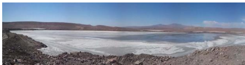
Fig. 3-19: Depósito de relaves espesados “Esperanza”. Fuente: SRK Consulting.
