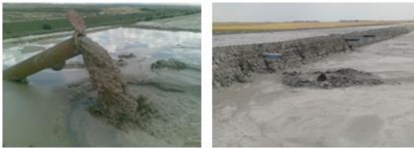
Fig. 3-15: Descarga de relave en método Paddock.
