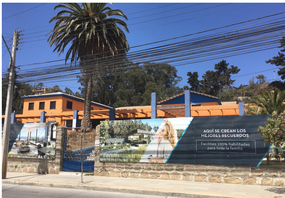
Fig. 62 Antiguo hotel próximo a ser demolido para la construcción de edificios de segunda vivienda en Algarrobo
