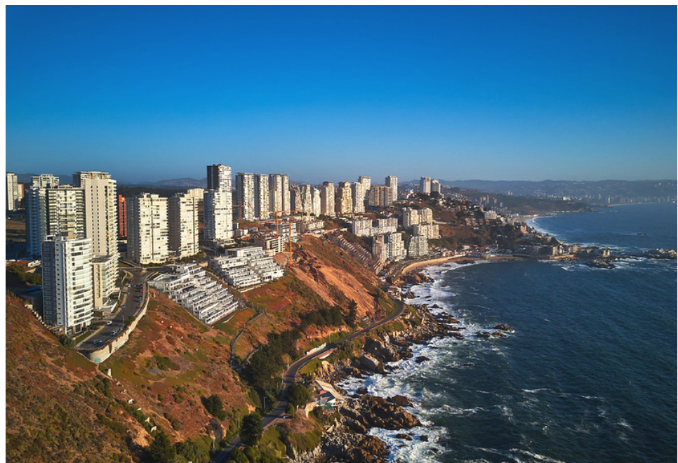
Fig. 58 Edificios construidos sobre el Campo Dunar de Concón
