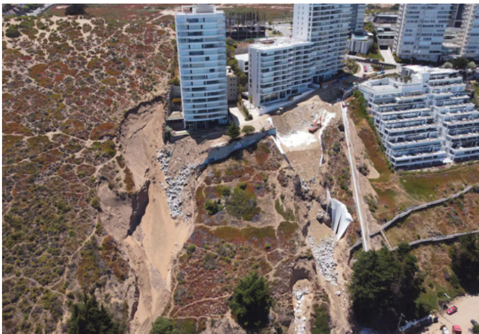
Fig. 59 Socavones de agosto de 2023 en Reñaca Norte
