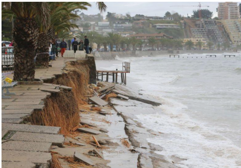
Fig. 55 Efectos de las marejadas en la erosión de la costa de Algarrobo en 2017
