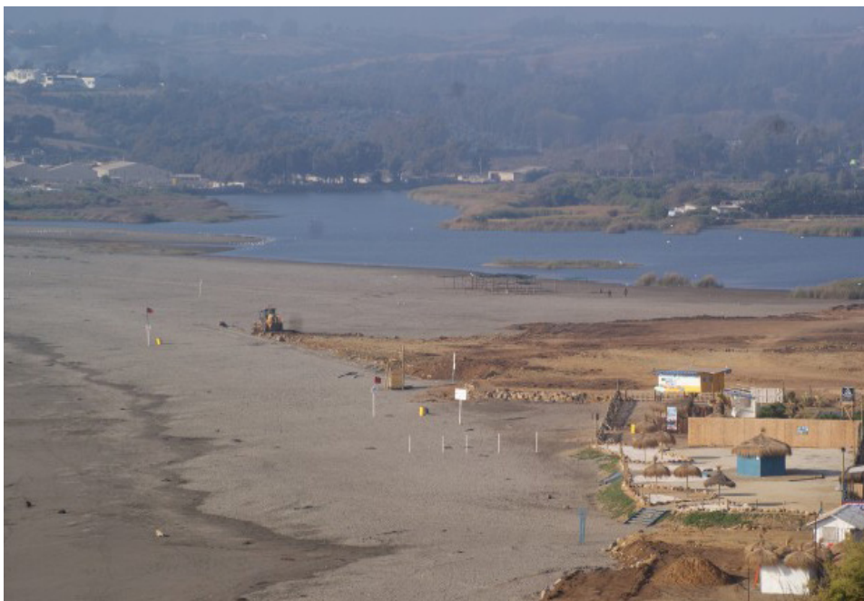
Fig. 57 Obras que cambiaron fisonomía de la playa La Boca y su humedal circa 2011.
