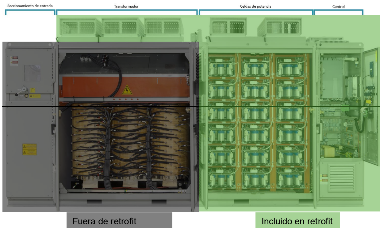
Figura 3-15: Componentes incluidos y excluidos del alcance de retrofit de los VDF XMV660. Fuente: Elaboración propia según sitio web power electronic.
