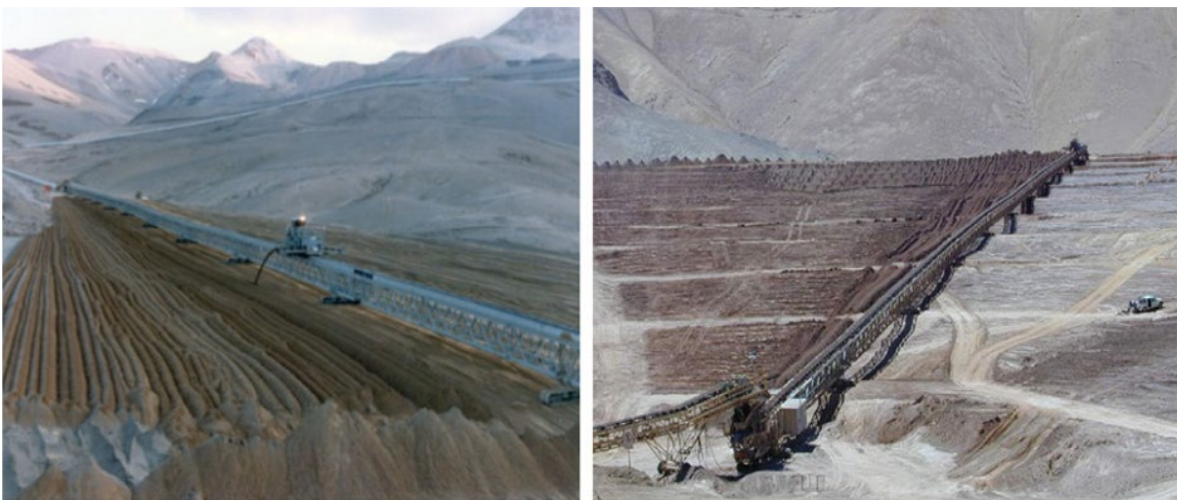
Figura 3-2: Depósito de relaves filtrados, Mina La Coipa, Chile (Cacciuttolo et al., 2023)
