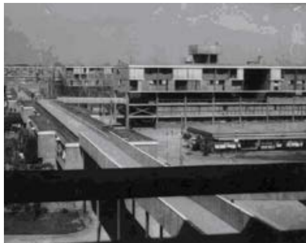
Figura 110 Vista block 8, puente y jardín. Año 1985.
