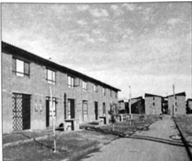
Figura 167 Proyectos de vivienda básica en Santiago de Chile.
