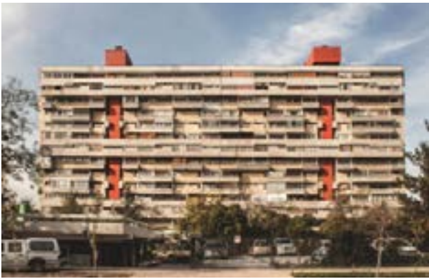
Figura 127 Vista del proyecto.
