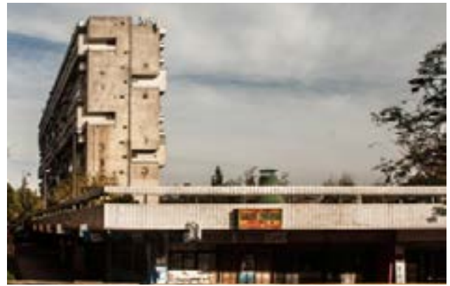
Figura 126 Vista del proyecto.
