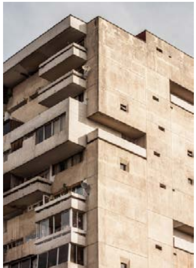
Figura 131 Vista del proyecto.
