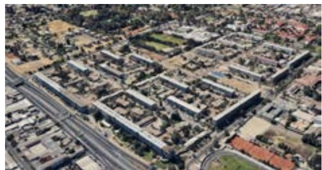
Figura 100 Exteriores del proyecto vista del año 1968.
