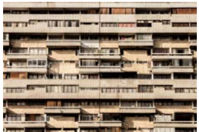
Figura 128 Vista del proyecto.
