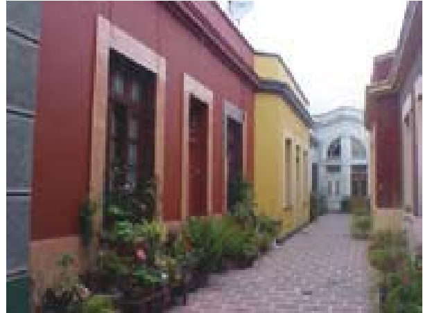
Figura 71 Vista interior pasaje. Remate de calle interior. Líneas de cornisas, antetechos, y trabajo en vanos de puertas y ventanas enriquecen el espacio interior.
