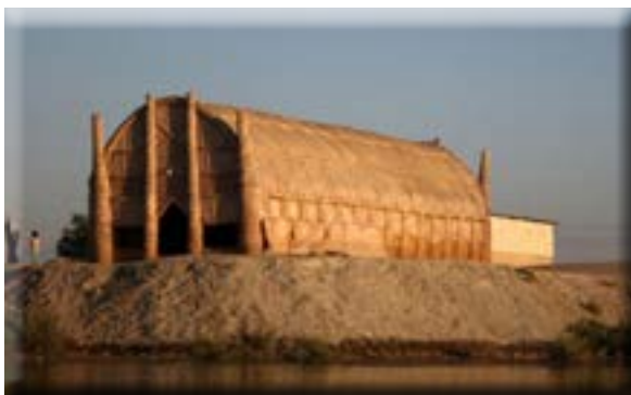
Figura 11. Siglo IX D.C Las viviendas Mudhif son una tipología de casa iraquí construida con base de paja, lodo y ramas de bambú. Esta arquitectura se originó en la región sur de Iraq entre los pantanos del y marismas de Mesopotamia. (Vigo, 2019)
