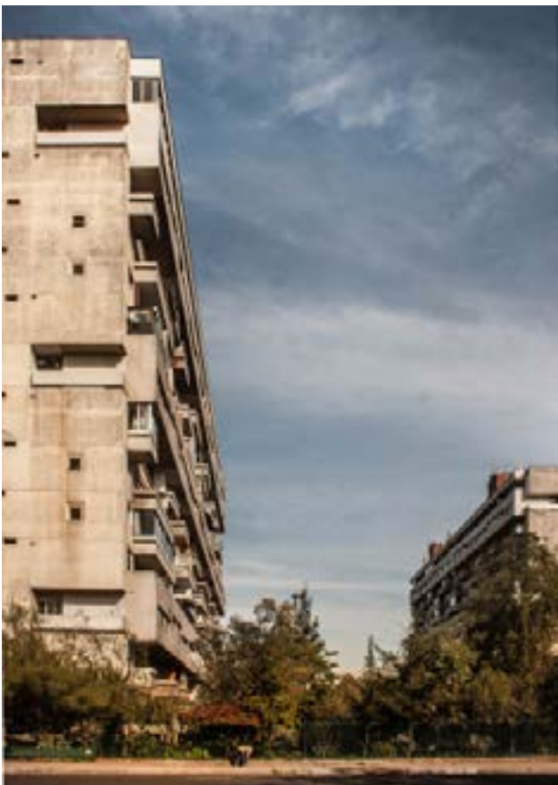
Figura 130 Vista del proyecto.
