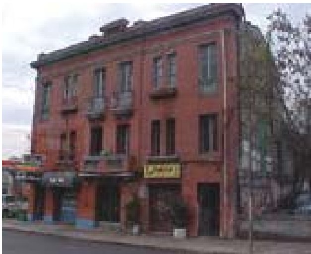
Figura 73 Vista exterior de la edificación. Al tener una composición en altura se constituye a nivel urbano como edificio.
