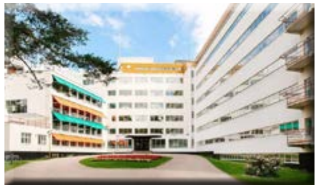
Figura 31 Vista patio interior altura humana.
