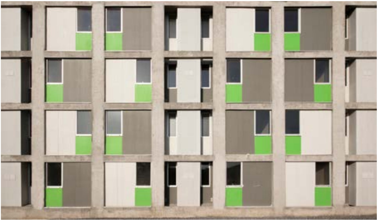
Figura 222 Piel exterior de la edificación.
