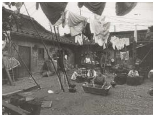
Figura 60 Conventillo de lavanderas, hacia 1900 Autor: Olds, Harry Grant, 1869-1943
