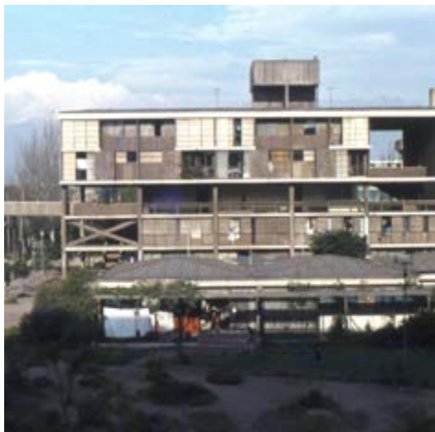
Figura 106 Vista block 8, puente y jardín. Año 1985.
