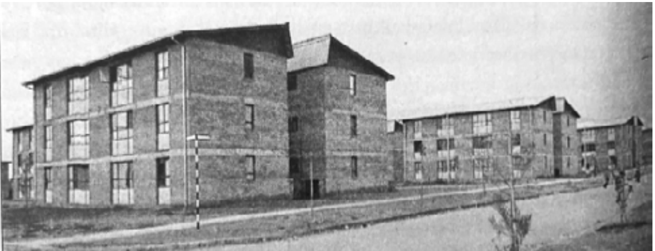
Figura 170 Proyectos de vivienda básica en Santiago de Chile.
