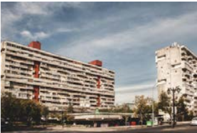
Figura 129 Vista del proyecto.
