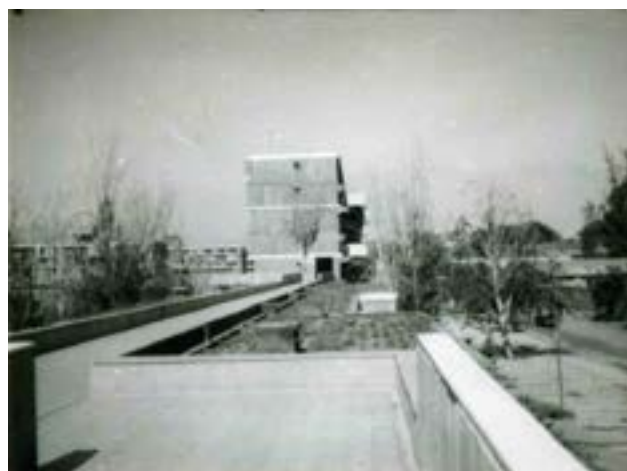
Figura 108 Puentes entre bloques sobre techos de casas. Año 1968.
