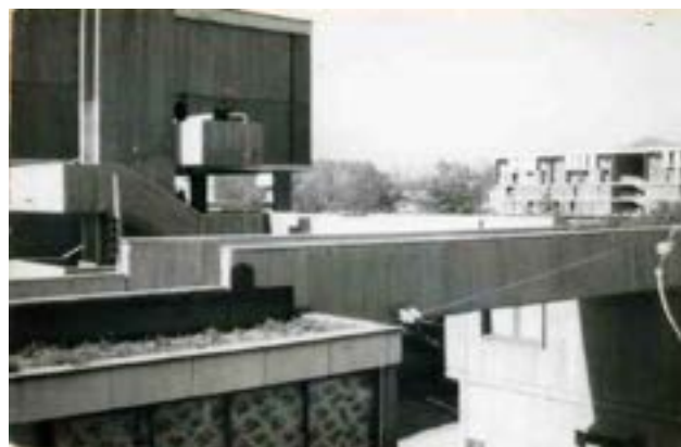
Figura 107 Puentes entre bloques sobre techos de casas. Año 1968.
