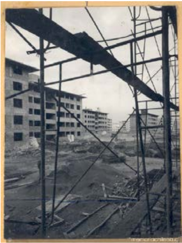
88 Imagen. Construcción de conjunto habitacional CORVI. Archivo Fotográfico y Digital. Fondo Quinta- na ; A8-0025
