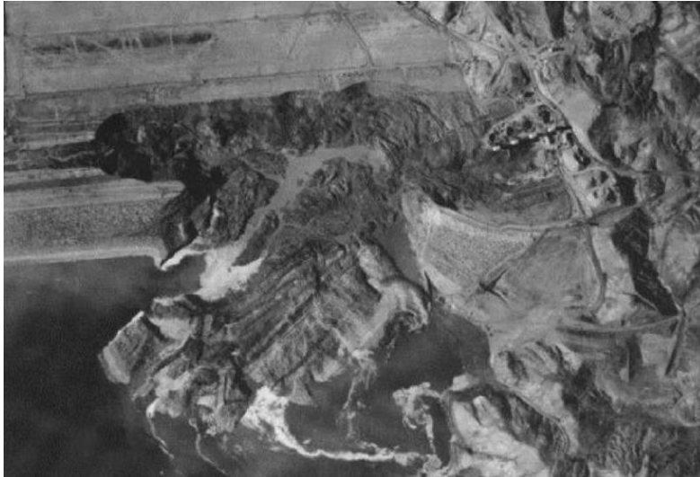
Figura 5-1: Fotografías aéreas de la falla del embalse Fort Peck. Fuente: Sigmundstad, 2015.
