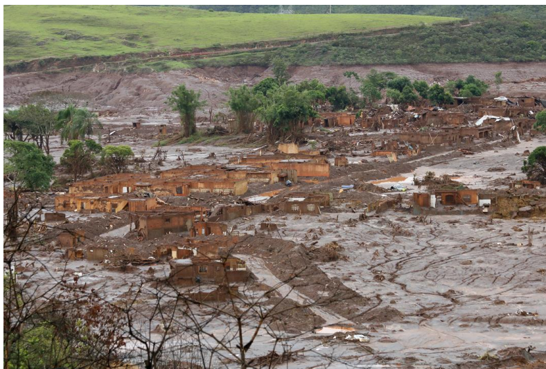
Figura 1-5: Colapso depósito de relaves Fundão, Espírito Santo, Brasil. Fuente: Mining Magazine, 2015.
