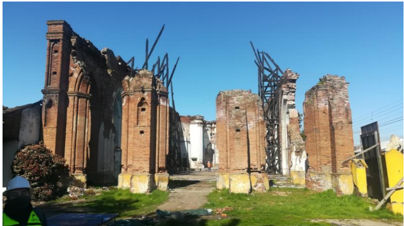
Figura 35. Fotografía de la Iglesia de San Francisco de Curicó, Región del Maule, comuna de Curicó. Fuente propia, cedida al Consejo de Monumentos Nacionales para el diagnóstico del proyecto de estabilización de la estructura de la Iglesia San Francisco de Curicó, año 2021.
