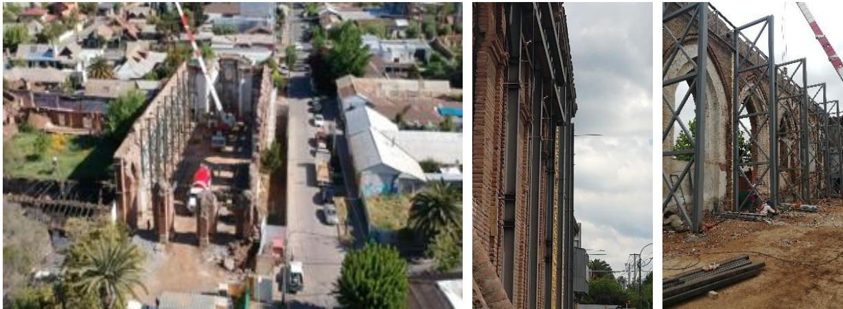
Figura 36 fotografía de la Iglesia San Francisco de Curicó. Instalación de estructuras de tipo ortésica para reforzar los paramentos de la iglesia que están con riesgo de colapso, año 2022/ Fuente: constructora ARCOS. -
