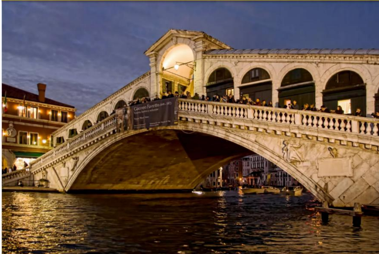
Figura 42. Fotografía del Puente de Rialto , Ciudad de Venecia/ Fuente.- https://chl.sika.com/es/proyectos-referencia/rialto-puente-venecia-italia.html .
