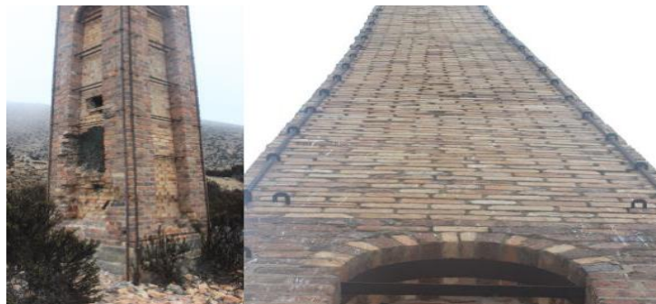
Figura 55 fotografía 1.- Registro fotográfico que detalla la configuración estructural de la Chimenea de Labrar. Año 2021./ Fuente: CEDOC-CMN
