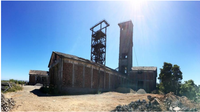
Figura 9. Fotografía de las cabrias (torres) de los piques Alberto 1 y Alberto 2, año 2020. Fuente: Elaboración propia, tomada y cedida por el autor al Consejo de Monumentos Nacionales para el informe de diagnóstico de conservación del complejo carbonífero de Chambeque.
