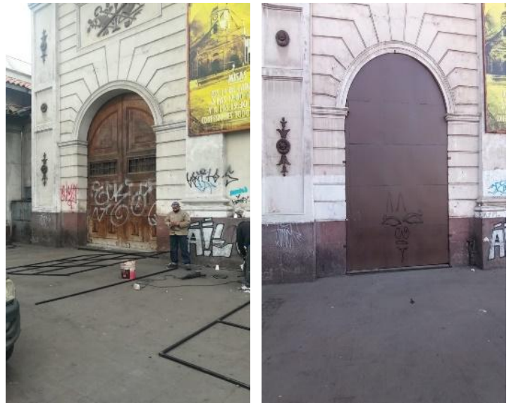
Figura 39 . Fotografías antes y después del acceso de la Iglesia Recoleta Franciscana, Comuna de Recoleta, Región Metropolitana, año 2020. Fuente: Elaboracion Propia
