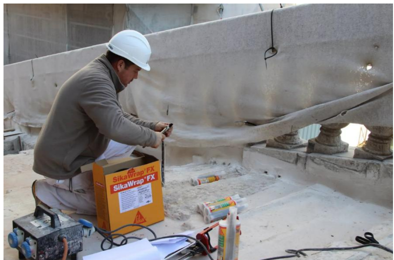
Figura 43. Fotografía de refuerzo con fibra de carbono / Fuente.- Sika Group
