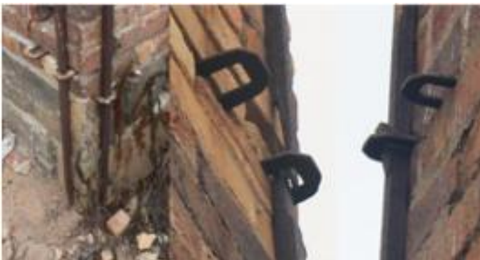
Figura 56 fotografía sistema de arriostramiento de las Chimeneas de Labrar. Año 2021. / Fuente: CEDOC-CMN
