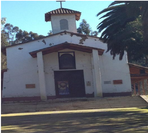
Figura 18 Fotografía de la Iglesia de Lora, Comuna de Licantén Región del Maule, año 2022. Fuente Elaboración propia.
