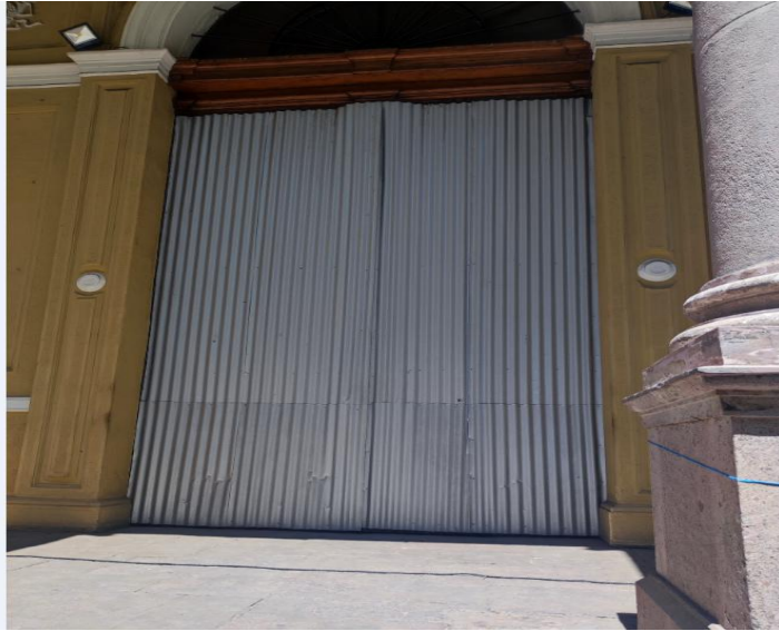
Figura 16. Fotografía de Iglesia de las Agustinas. Se observa la colocación de láminas de acero zinc-alum. año 2024. Fuente: Elaboración propia.
