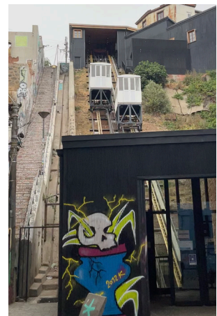
Figura 110. Ascensor Cordillera. Fuente: Archivo personal.
